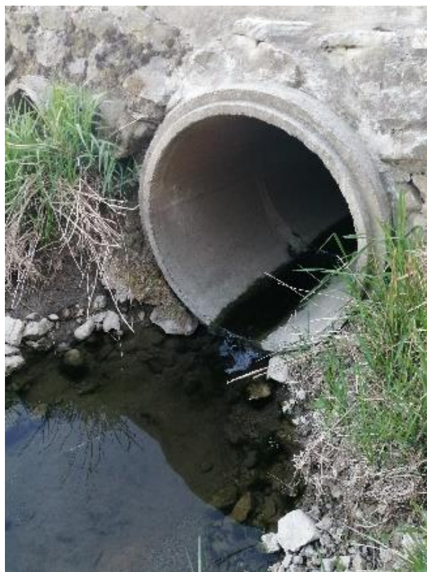
Slika 5. Kanalizacija pri vasi Klenik (vir: Doroteja Vidmar Gajšek)
